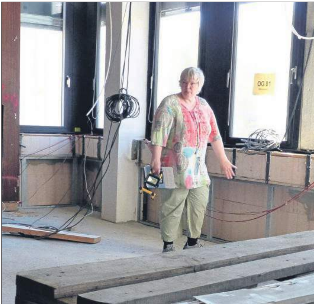
Ute Listmann in einem der Fraktionsbüros. Neben dem Sichtbeton stehen auch die Holzvertäfelungen unter Denkmalschutz und dürfen nach Abschluss der Arbeiten nur behutsam gereinigt werden.
